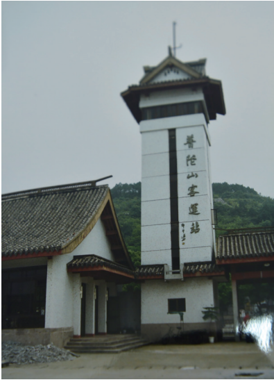
写着站名的水泥钢筋塔,2004年被拆除
