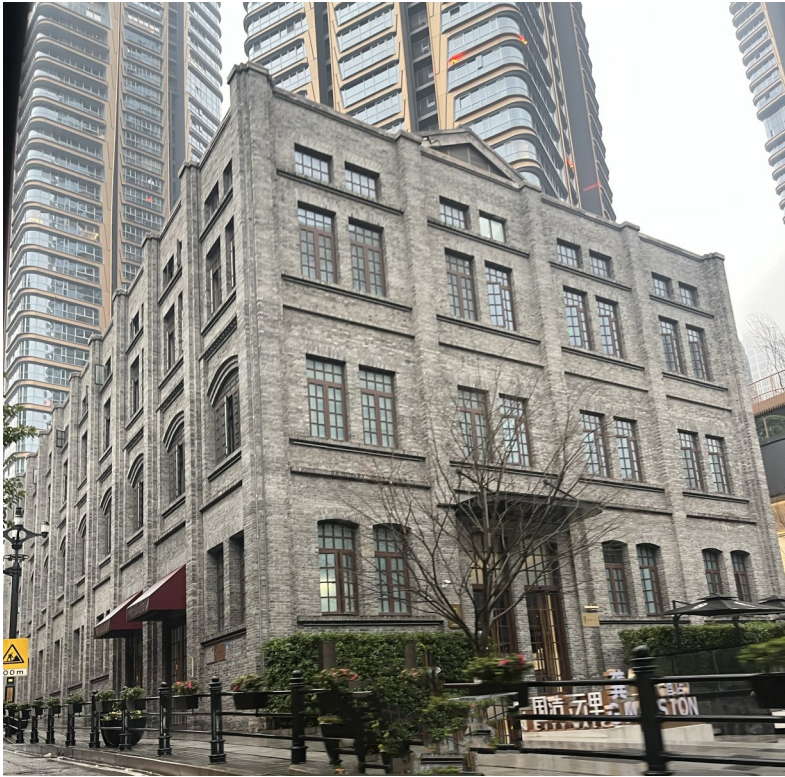
重庆火柴原料厂旧址
