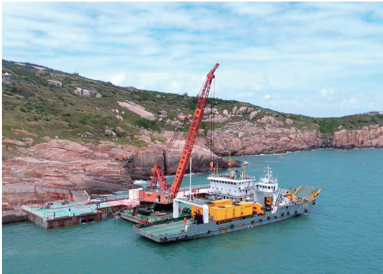
东极 2000 千瓦集装箱式应急发电车吊装
