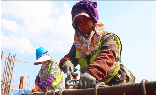
舟山市高铁新城回字形综合体工程工地，全副武装的钢筋女工在烈日下绑扎钢筋
