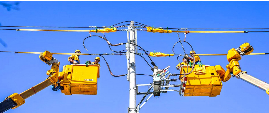
电力工人在普陀变10千伏农都线开展带电搭开关引线工作，采用不停电施工模式完成线路升级，保障辖区群众与商户夏日用电稳定可靠 通讯员 张帆 摄
