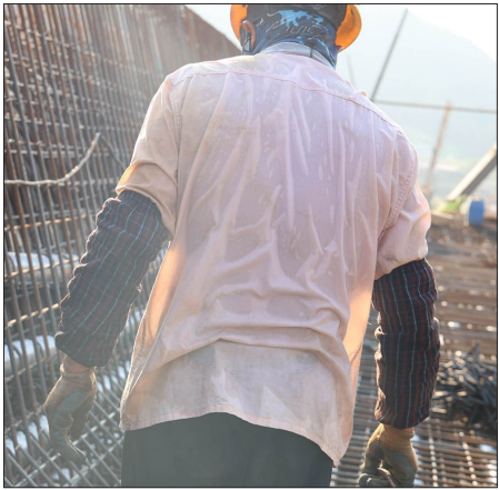
甬舟铁路舟山站特大桥工程工地，一名钢筋工的衣衫已经湿透
