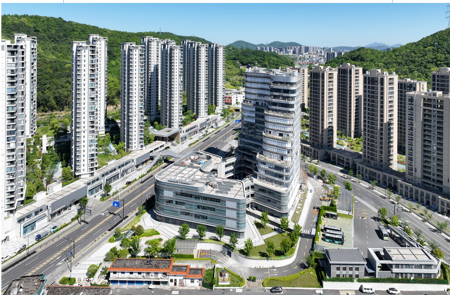
近日,航拍下的未来社区市民中心主体建筑设计新颖时尚,成为定海城西片区的靓丽新地标。记者 陈永建 摄
