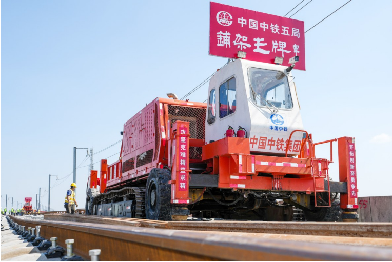
10月14日,中铁五局施工人员操纵牵引车进行铺轨作业。 10月14日,通甬高铁全线铺轨正式启动。通甬高铁是我国“八纵八横”高铁网沿海通道的重要组成部分,建成后将进一步完善长三角地区高速铁路网布局,推动长三角高质量一体化发展。 新华社记者 李博 摄
