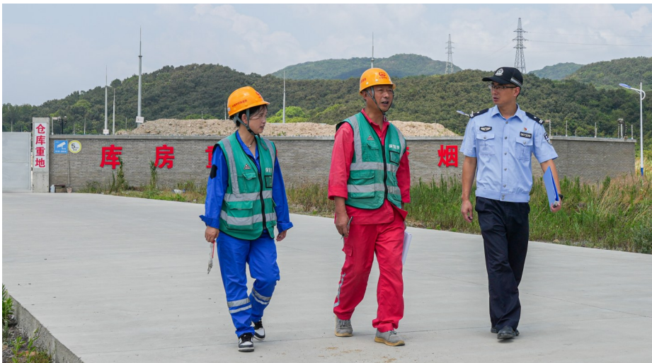
图为陈都在爆破作业现场开展安全检查
