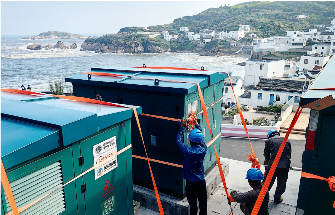
国网舟山供电公司工作人员加固海岛电力设备设施 摄影 通讯员 吴嘉腾 记者 邢楠
