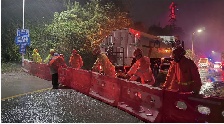
普陀山公运中心实施临时封路，清理公路沿线倒伏树木
