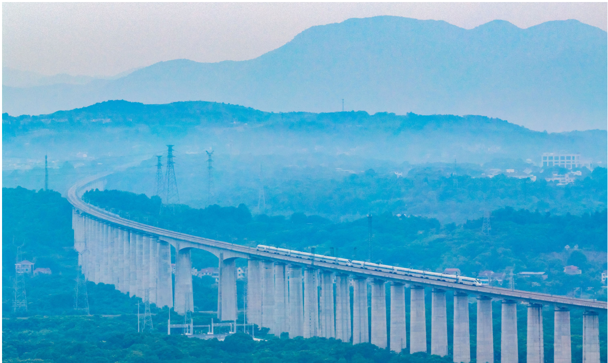
6月27日，列车行驶在杭台高铁嵊州特大桥上（无人机照片） 新华社 发 为实现智慧化运营管理，杭绍台铁路有限公司联合高校开发了运输经营智能分析系统，并在沿线创新布局铁路智能安全监测体系，打造以分布式光纤传感技术为核心的“空天地”一体化智能监测系统，切实守护运营安全。 作为我国首批8个社会资本投资铁路示范项目之一，杭台高铁在建设和运营过程中，突破了多个
