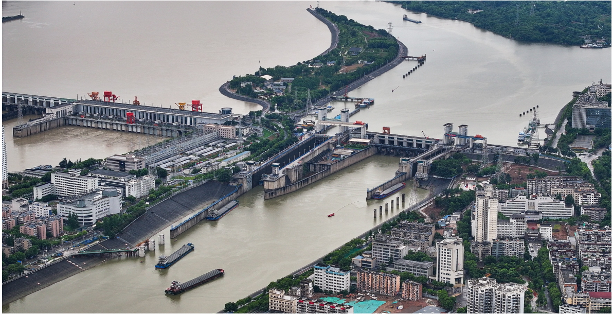
6月8日拍摄的三峡水运新通道工程葛洲坝航运扩能施工现场
