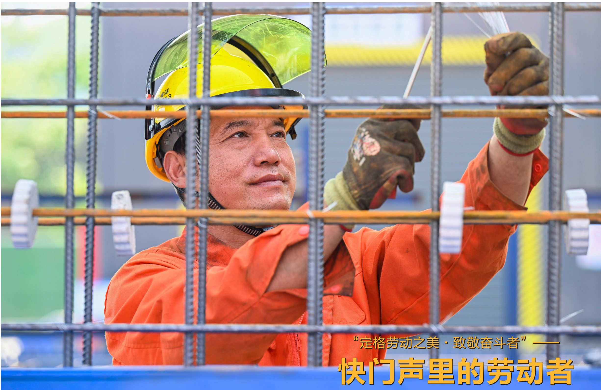
甬舟高速复线二期富翅岛施工现场,工人正在绑扎钢筋
