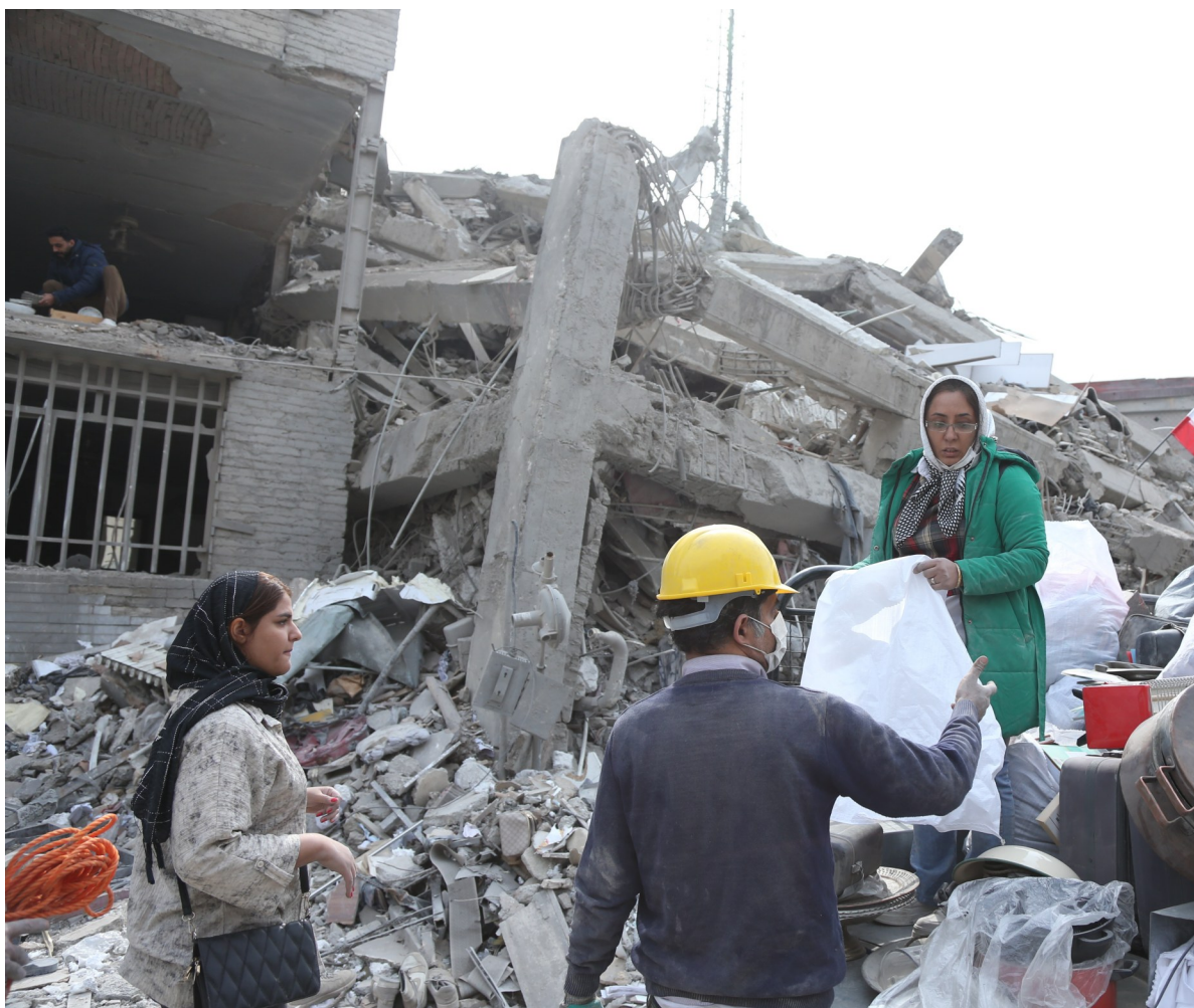
3月12日,在伊朗德黑兰东部一处居民区,市民把物品从被毁的房屋中找出后装车 新华社记者 沙达提 摄
