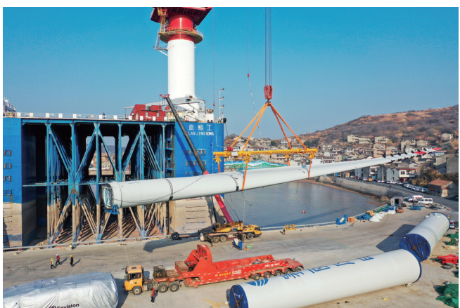
巨大的白色风机叶片被浮吊船上的起重机缓缓吊起，准备装车
