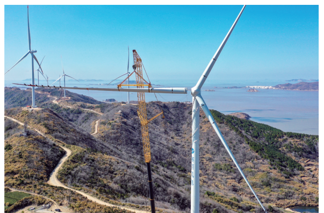
起重机正在将一片叶片精准地吊装到位
