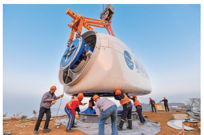
黄昏时分，多名工人协力引导机舱起吊离开地面
