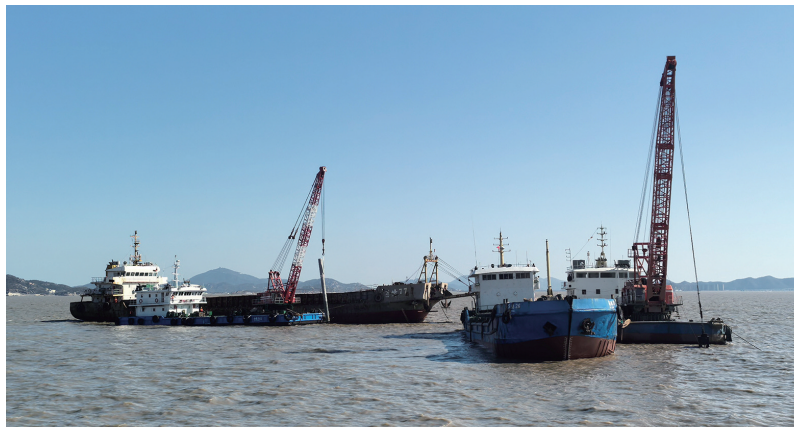
管桩施工则是为防波堤建设打基础。
