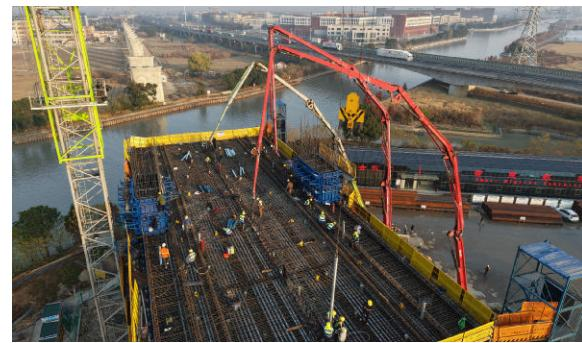
12月20日,中铁十六局建设者在通甬高铁嘉兴特大桥跨杭申线航道矮塔斜拉桥连续梁0号块浇筑施工现场作业(无人机照片)。12月19日起,位于浙江省嘉兴市南湖区的新建南通至宁波高速铁路(简称通甬高铁)嘉兴特大桥跨杭申线航道矮塔斜拉桥连续梁0号块持续进行浇筑施工,将为后续桥梁上部结构推进奠定基础。通甬高铁是我国“八纵八横”高铁网沿海通道的重要组成部分,建成后将进一步完善长三角地区高铁网布局,推动长三角高质量一体化发展。新华社记者 黄宗治 摄
