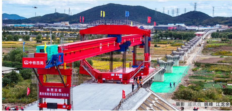
设518榀箱梁,其中,由中铁四局承建的6工区共需铺设129榀箱梁。按照一天架设2~3榀的进度,6工区预计在今年春节前完成箱梁预制和架设工作。
