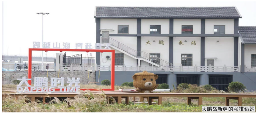
大鹏岛新建的强排泵站
