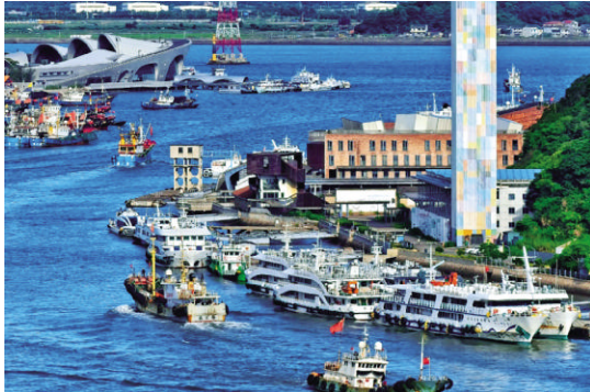
沈家门渔港半升洞码头、鲁家峙海蓝景美 图片来源:普陀潮客户端
