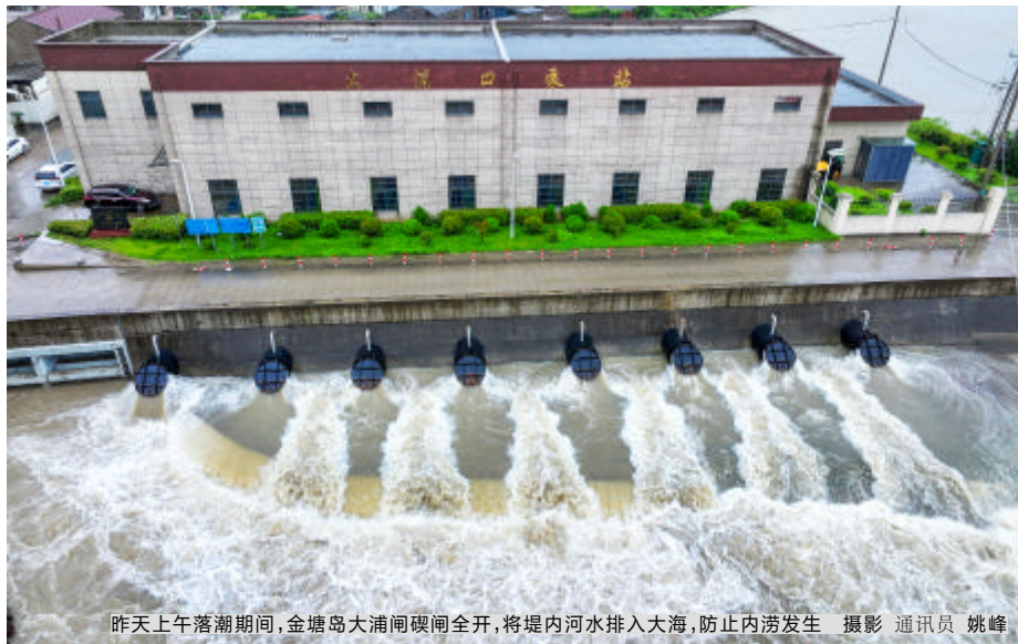
昨天上午落潮期间,金塘岛大浦闸闸閘全开,将堤内河水排入大海,防止内涝发生 摄影 通讯员 姚峰
