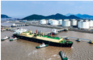
浙江自贸试验区舟山片区LNG保税仓库迎来首艘LNG轮
