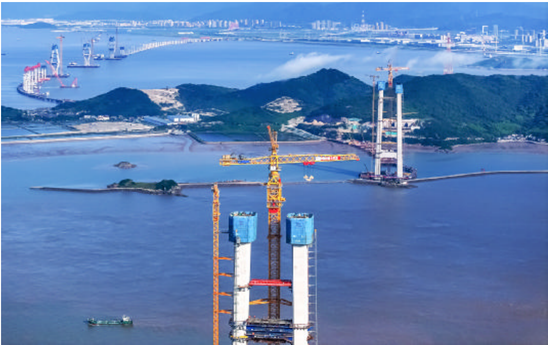
正在建设中的宁波舟山港六横公路大桥
