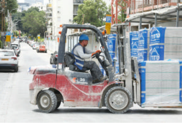
6月24日,在以伊停火协议生效后,工人在以色列特拉维夫的一处工地工作
