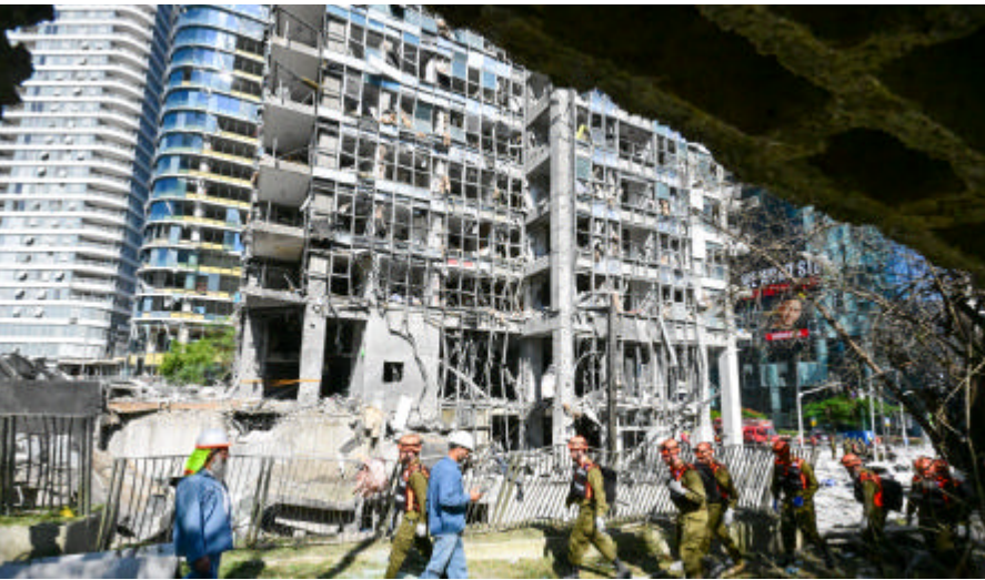
6月19日,应急和救援人员在以色列中部拉马特甘的导弹袭击现场开展工作。据《以色列时报》19日报道,根据以色列国防军评估,伊朗在当天早上的袭击中对以色列发射了约30枚弹道导弹。 新华社发(约西·泽利格勒 摄/基尼图片社)
