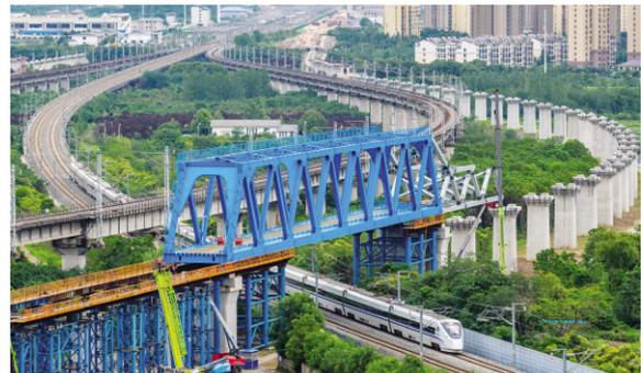
新建沪宁合高铁钢桁梁跨越沪蓉铁路(6月15日摄,无人机照片)。
