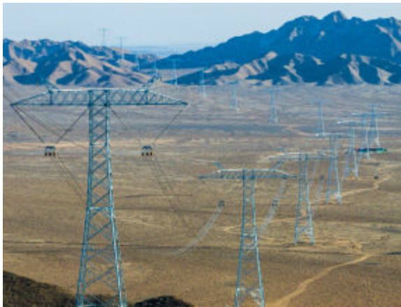
哈密—重庆±800千伏特高压直流输电工程(新疆段)在东天山山区架设导线(2024年10月30日摄,无人机照片) 新华社 发(吴世平 摄)
