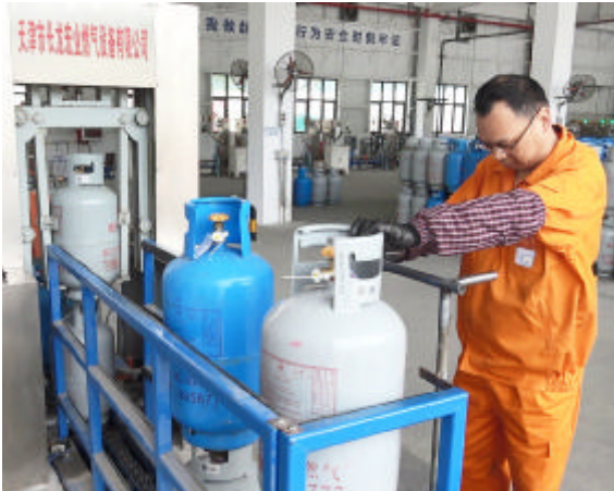
市蓝焰燃气液化气分公司新建成的充装车间 摄影 记者 何斌
