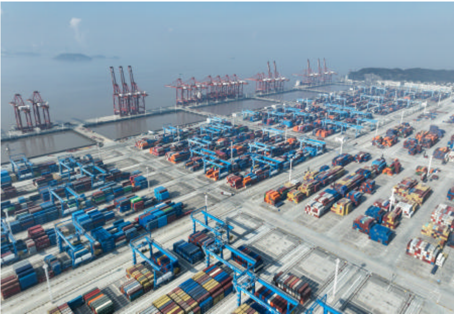
在浙江宁波舟山港金塘港区大浦口集装箱码头，货轮在泊位上有序装卸集装箱（无人机照片，2025年1月4日摄） 新华社 邹训永 摄）
