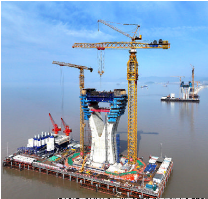
青龙门大桥中塔全部进入塔柱上部结构施工阶段 摄影 通讯员 姚峰 王双奇
