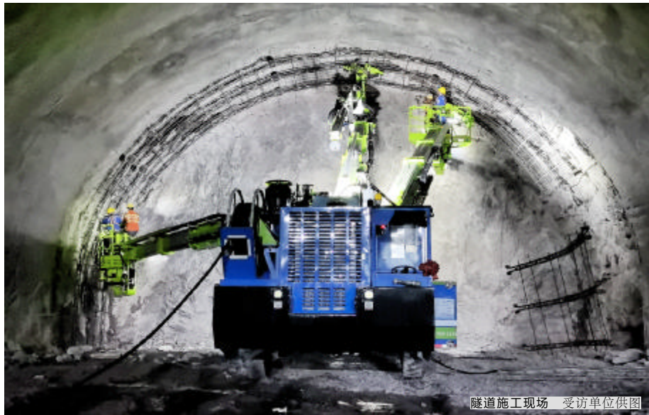
隧道施工现场 受访单位供图
