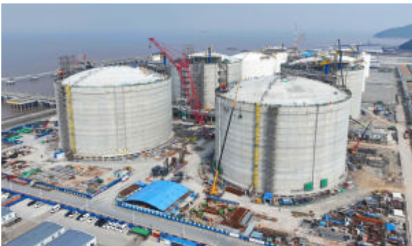
新奥舟山LNG接收及加注站三期项目将建设4个22万立方米LNG储罐及配套设施,目前正全力推进中 摄影 记者 陈永建
