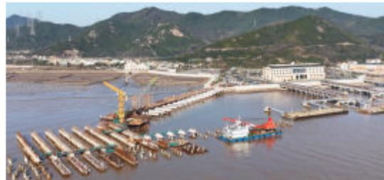
4月6日,六横大岙码头改扩建工程进入224米引桥预制孔芯板铺设阶段,预计本月中旬完成全部227块孔芯板铺设。总长358米的大岙码头工程计划于今年11月全面完工。 摄影 通讯员 刘生国
