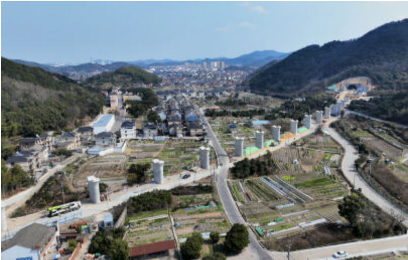
甬舟铁路施工
