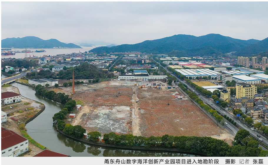
甬东舟山数字海洋创新产业园项目进入地勘阶段 摄影 记者 张磊
