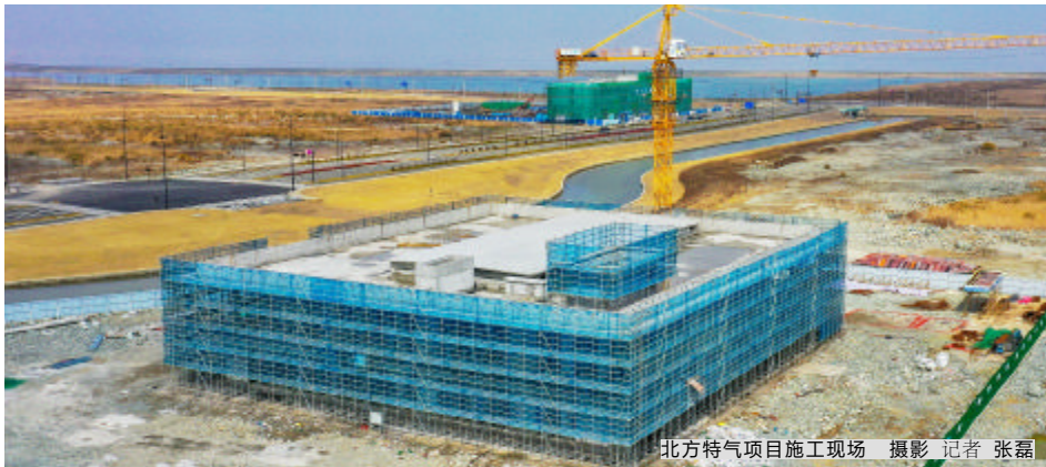
北方特气项目施工现场 摄影 记者 张磊
