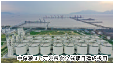
中储粮50.4万吨粮食仓储项目建成投用
