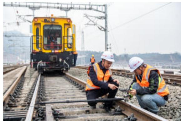
2月18日,在重庆东站建设施工现场,铁路工人在对线路进行精调作业。当日,中铁十一局、成都铁路局重庆工务段的工人在大型捣固车、钢轨打磨车等大型机械的协助下,在重庆东站建设施工现场进行轨道铺设完毕后的精调工作。
