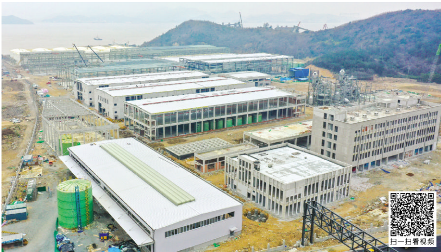
浙江聚泰新能源材料有限公司的一期项目土建施工基本结束，主体已进入设备安装阶段 摄影 记者 张磊
