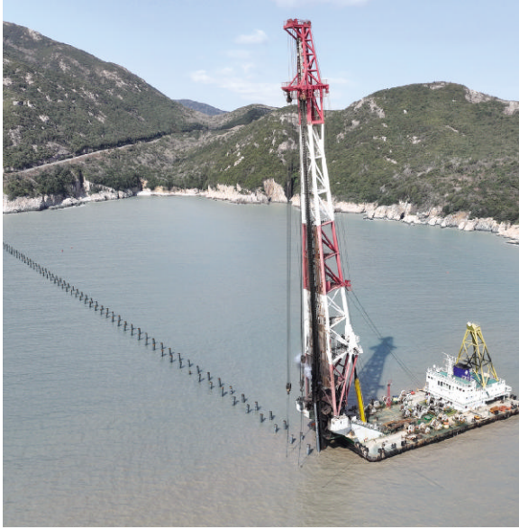
桃花大黄鱼围栏野化养殖项目正进行沉桩作业 摄影 通讯员 方碧蓉
