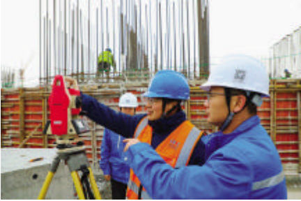
春节期间,国投吉能(舟山)2×745兆瓦级燃气发电项目持续拉满施工“进度条”,100多名工人坚守岗位
