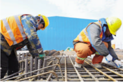
春节期间,金塘新材料项目现场,一批建设者坚守岗位,确保工程进度
