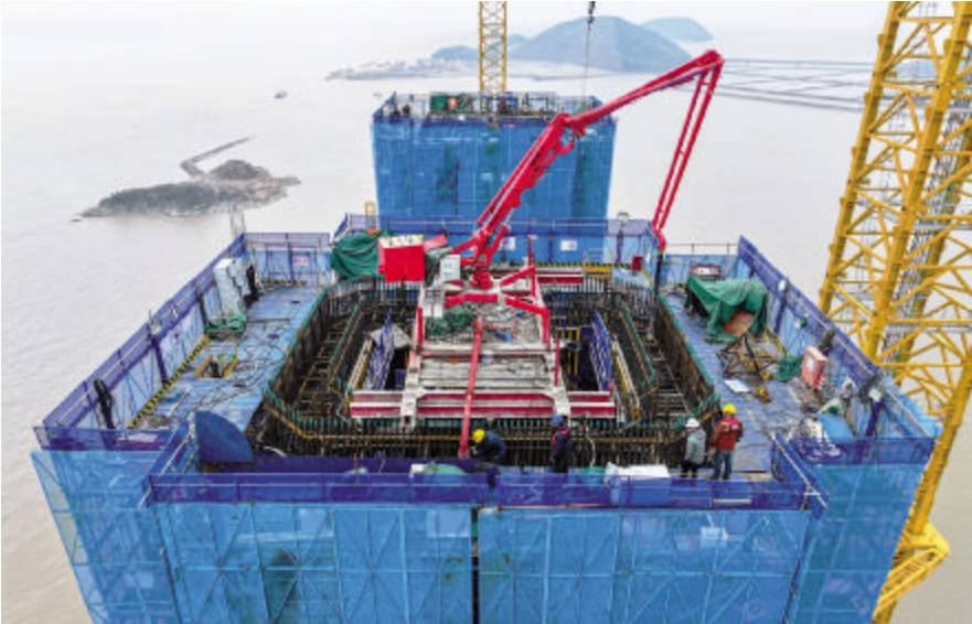
2月2日,宁波舟山港六横公路大桥二期工程——双屿门特大桥佛渡岛侧施工现场,400多名建设者坚守关键岗位,为后续工程打基础
