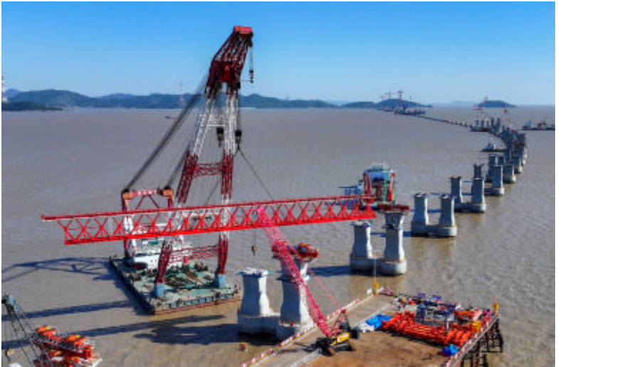
2024年11月28日,宁波舟山港六横公路大桥二期工程的青龙门特大桥建设现场,一件长84米、重200吨的架梁机主梁正吊装,标志着青龙门特大桥西引桥进入架梁施工 图/姚峰
