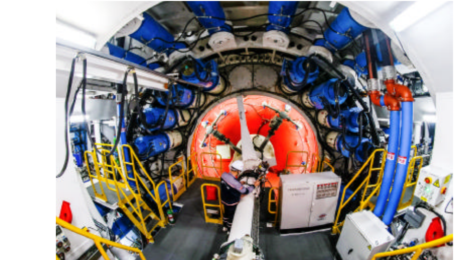
2024年10月22日,“定海号”盾构机成功穿越金塘岛海堤,由陆域段进入海域段掘进施工,标志着甬舟铁路金塘海底隧道开启“穿海之旅” 图/姚峰
