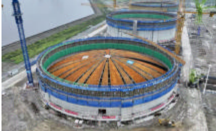
2024年6月27日,浙能舟山六横LNG接收站项目4座22万立方米储罐穹顶全部吊装完成 图/周志南
