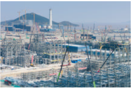
2024年12月,正在建设中的金塘新材料产业园 图/姚凯乐
