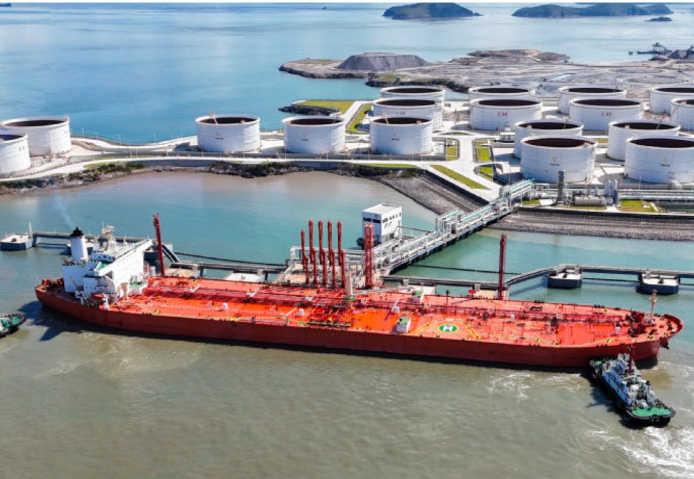
2024年8月18日,载运10万吨原油的巴拿马籍“瑞尼”轮顺利靠泊宁波舟山港六横港区东白莲油品码头1号泊位,这是该码头获批临时开放后迎来的首艘外轮 图/陈霆
