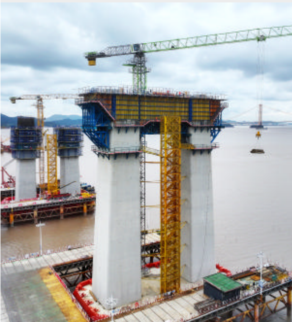
昨天,甬舟铁路西堠门公铁两用大桥施工现场,施工者正在2号墩顶开展清理作业。随着墩帽混凝土完成浇筑,2号墩完成全部下部结构施工,为下步边跨钢梁架设奠定了基础。摄影 通讯员 姚峰
