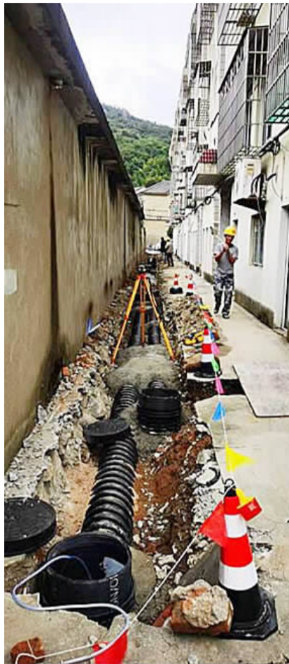
管道施工期间现场
