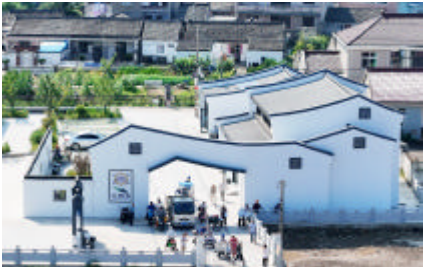
定海大鵬岛客运码头焕然一新
