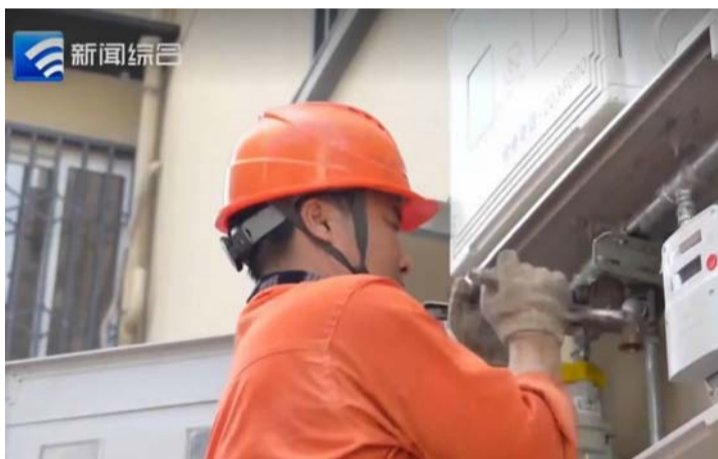
蓝焰燃气公司工人正在施工中
