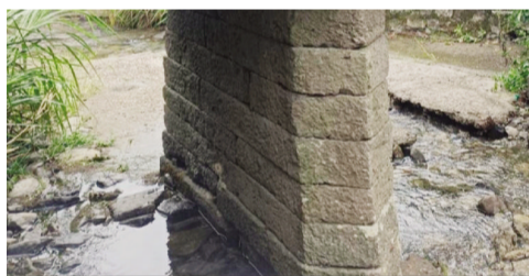
桥墩上整齐一致的尖形迎水面
