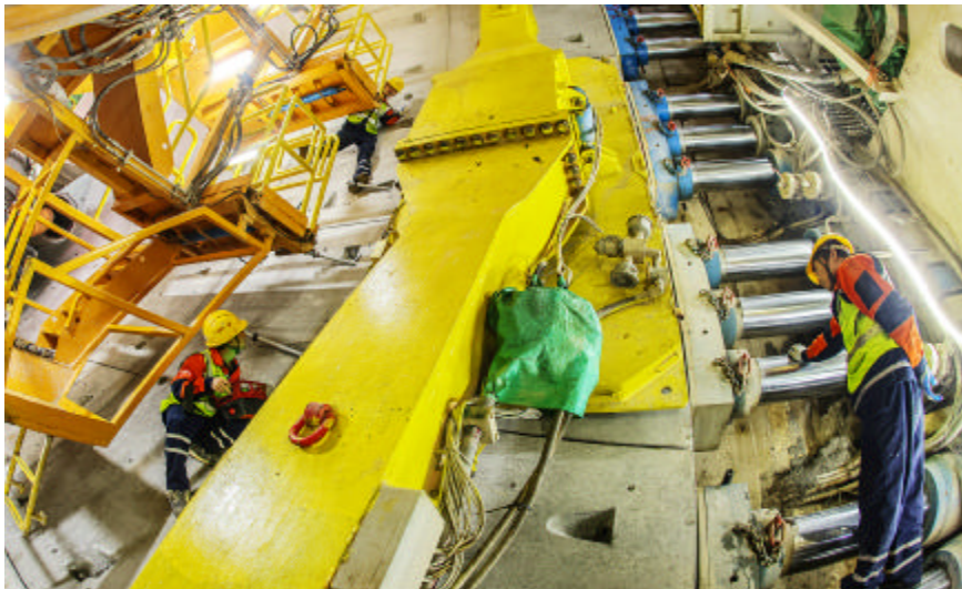
甬舟铁路金塘海底隧道舟山侧施工现场，中铁十一局集团的工人们在40多米深的海底进行盾构掘进、箱涵吊装、管片拼装，现场忙碌有序
