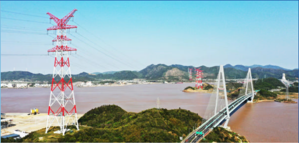
▲舟山500千伏联网工程
