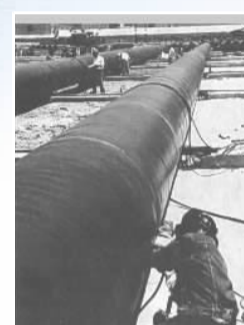
1998年，工人们在焊接大陆引水工程管道
