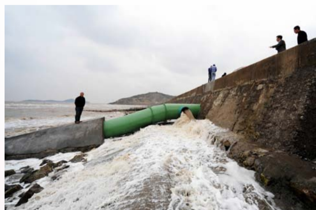
我市大陆引水二期工程应急输水管道成功通水
