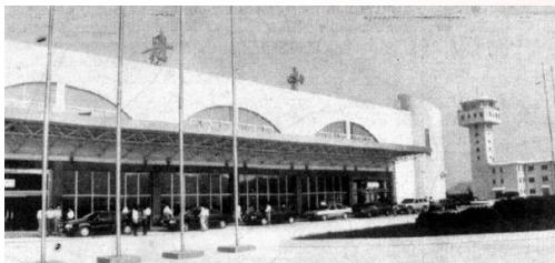
舟山(朱家尖)民航机场候机大楼一角
