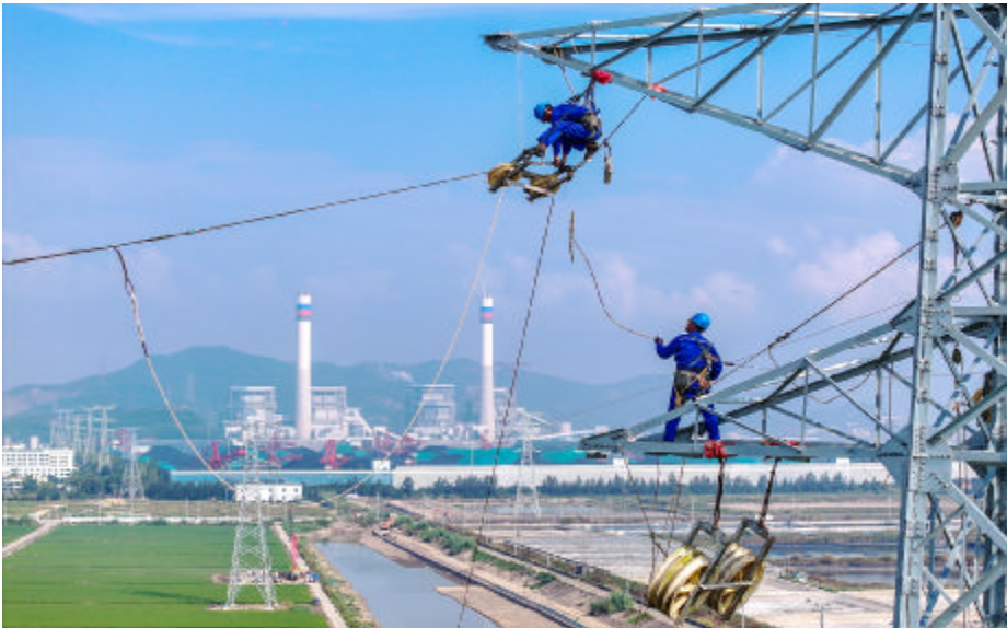
六横岛新建220千伏输电线路日前开始架线。该线路始于六横电厂，止于岑山变电站，全长6.242千米，计划于今年10月下旬投运，将为六横岛的经济发展起到重要的保障作用。摄影 通讯员 姚峰 张帆 蒋秋凤
