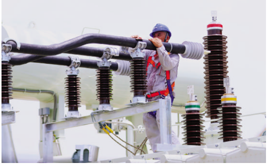
华润电力岱山双剑涂二期渔光互补项目正在加紧建设中 图/陆志杰
