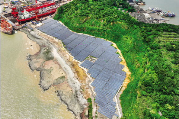
位于舟山万邦永跃船舶修造有限公司内的滩涂光伏发电站 图/邹训永
