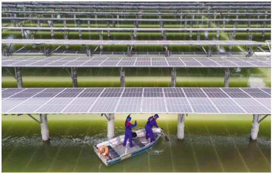
岱山县大长涂岛南面滩涂上,国网舟山供电公司启明集团运维人员划船开展光伏板运维巡视 图/姚凯乐
