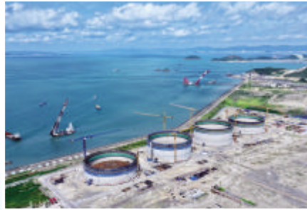
浙能舟山六横LNG接收站项目现场
